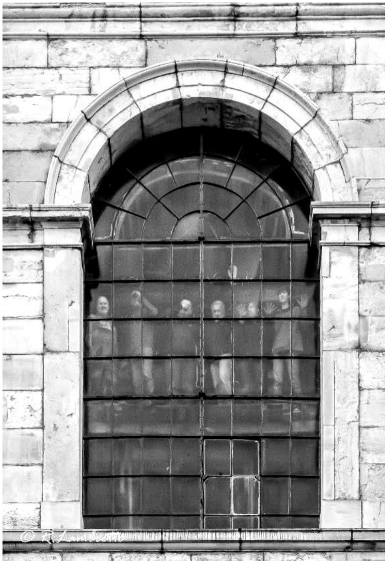
L'équipe de démonteurs à l'emplacement de l'horloge à l'arrière de la baie vitrée en façade de St-Remacle
