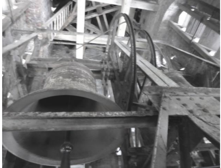
Vue générale du bâti des cloches
