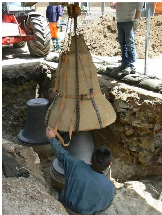
Installation des moules de cloches dans la fosse de coulée
