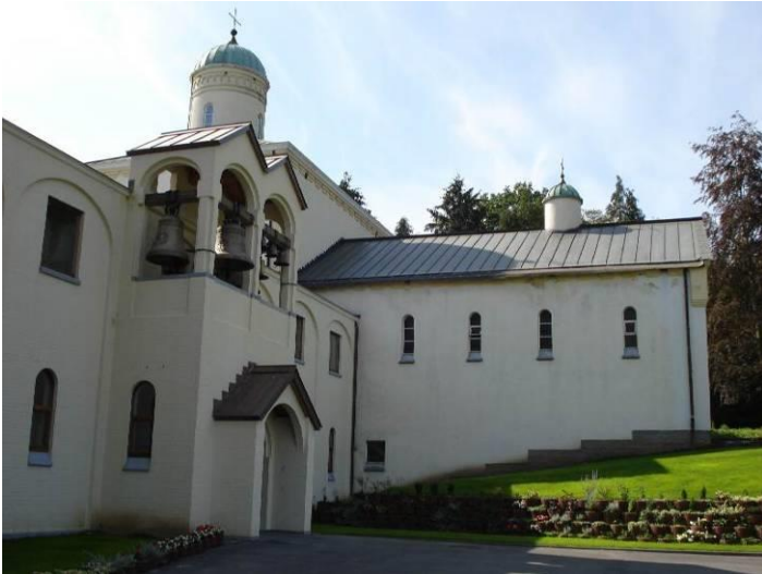
Le balcon-clocher abritant la sonnerie byzantine
