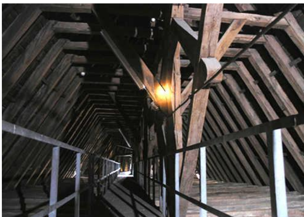
Charpente au-dessus de la voûte du chœur gothique
