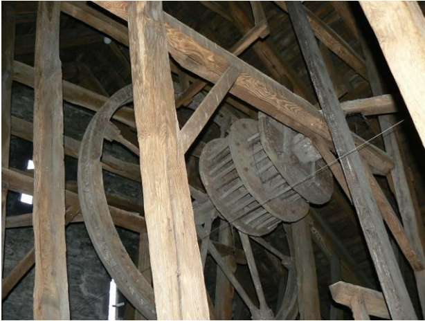
Dispositif de levage dans la charpente du transept
