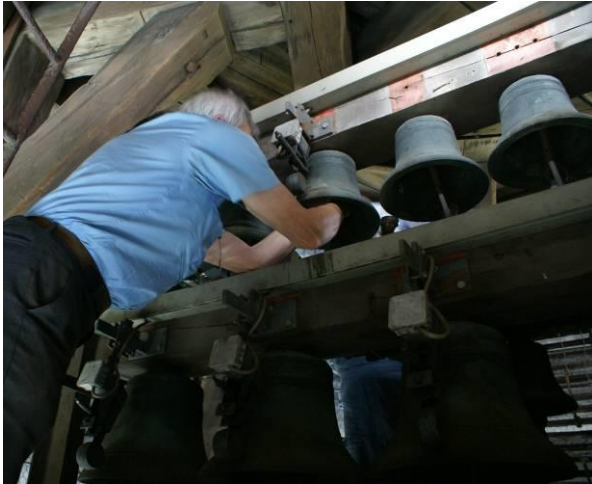
À gauche : réglage de la fixation des battants À droite : réglage de la tension des câbles
