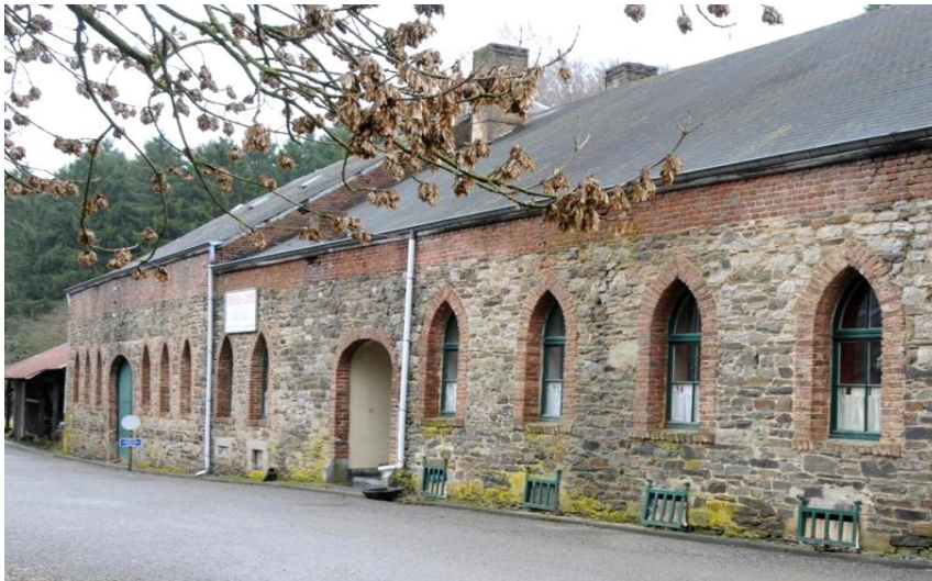
L'ancienne fonderie Causard-Slégers à Tellin
