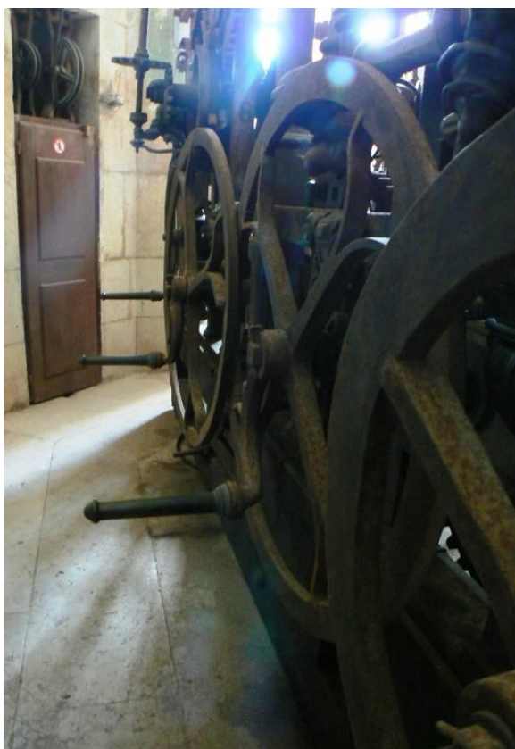
Tour nord : roues et manivelles pour le remontage des poids des 4 barillets
