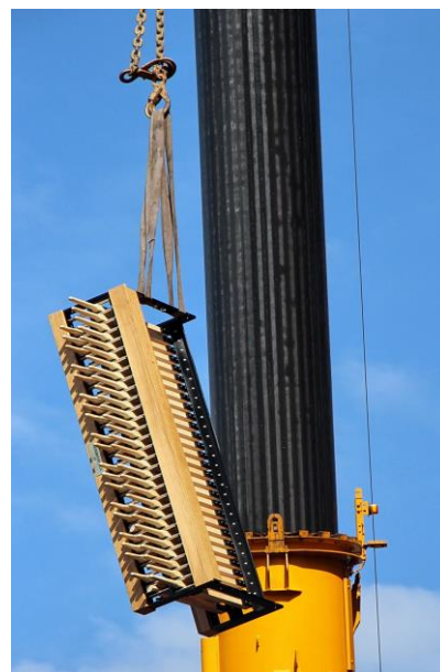
Cloches et clavier de carillon hissés vers la tour Sud de la collégiale
