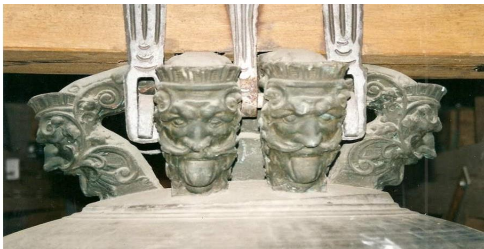
Têtes d'homme sauvage sur la couronne du bourdon (4.864 kg) de l'abbaye de Maria Laach (Allemagne), produit par la Fonderie A. Causard à Tellin
