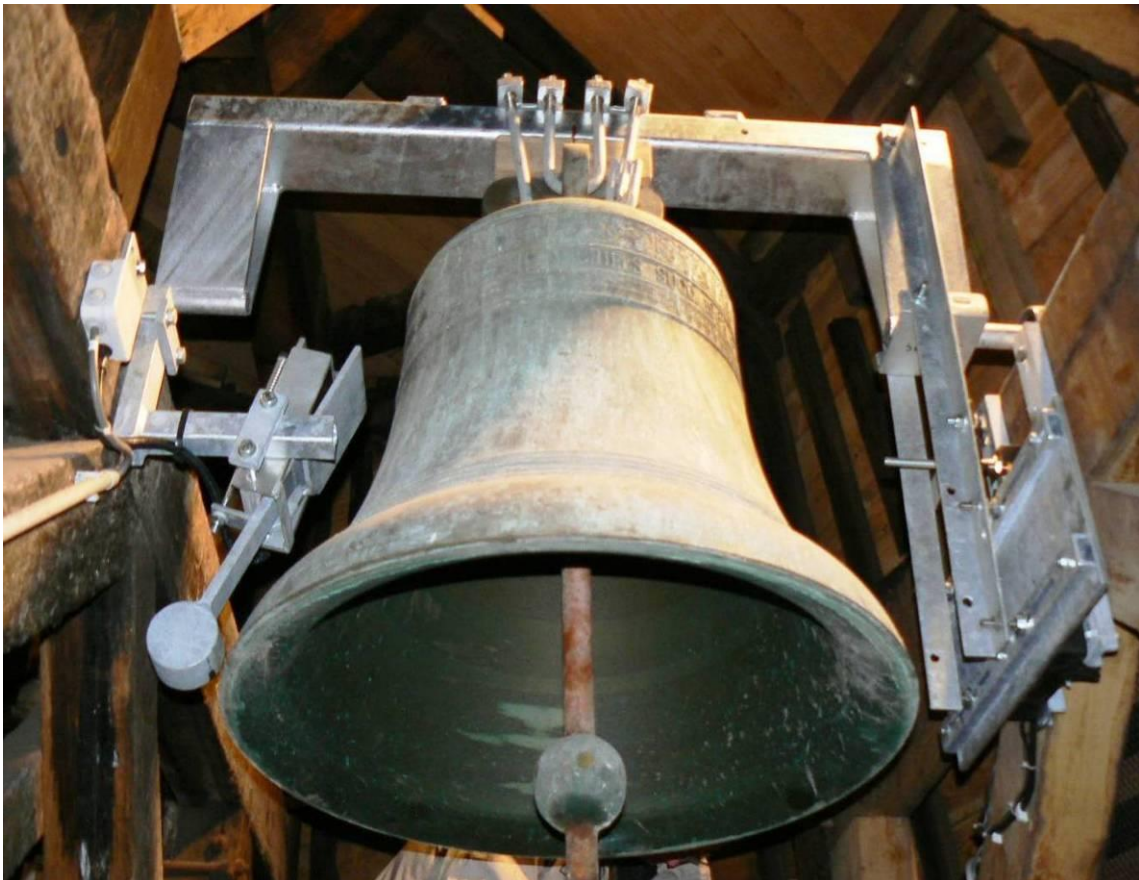
Église N.-D. de Seraing : cloche équipée d'un moteur linéaire (à droite) et d'un tinteur (à gauche)
