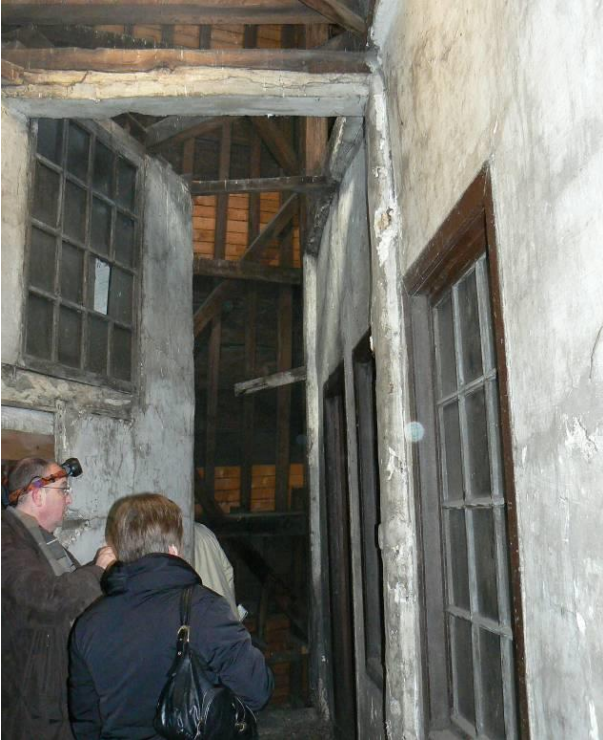
Dans le clocher, à droite, le local abritant l'horloge d'édifice et la machine à carillonner
