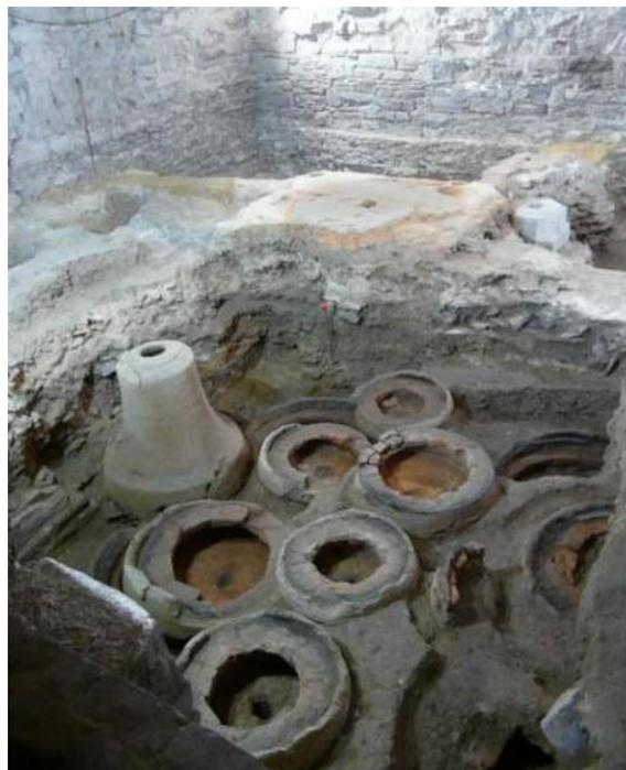
*Atelier de fonte de cloches sous le rez-de-chaussée du beffroi*
