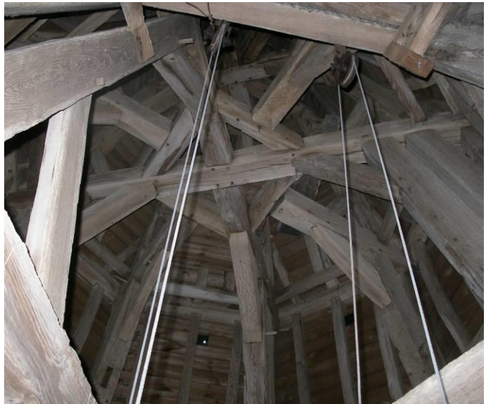
Système de poulies pour allonger la course des poids
