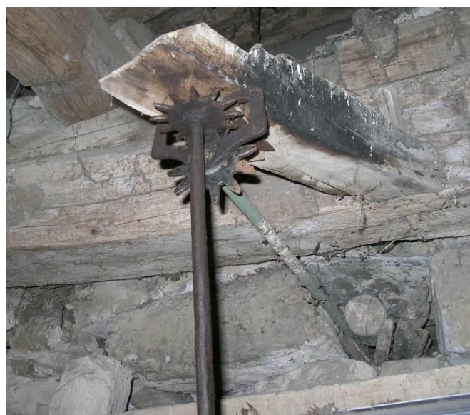
Partie terminale du mécanisme de renvoi des heures vers le cadran
